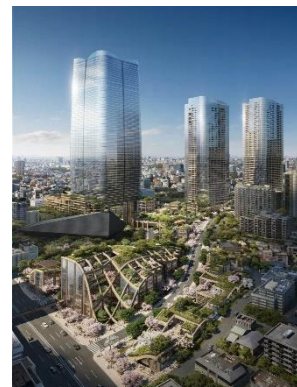
麻布台ヒルズ(清水建設)
