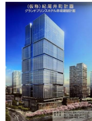
(仮称)紀尾井町計画 グランドプリンスホテル赤坂建設計画 紀尾井町再開発(鹿島建設)
