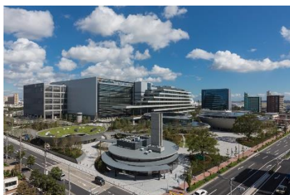
羽田物流ターミナル(鹿島建設)
